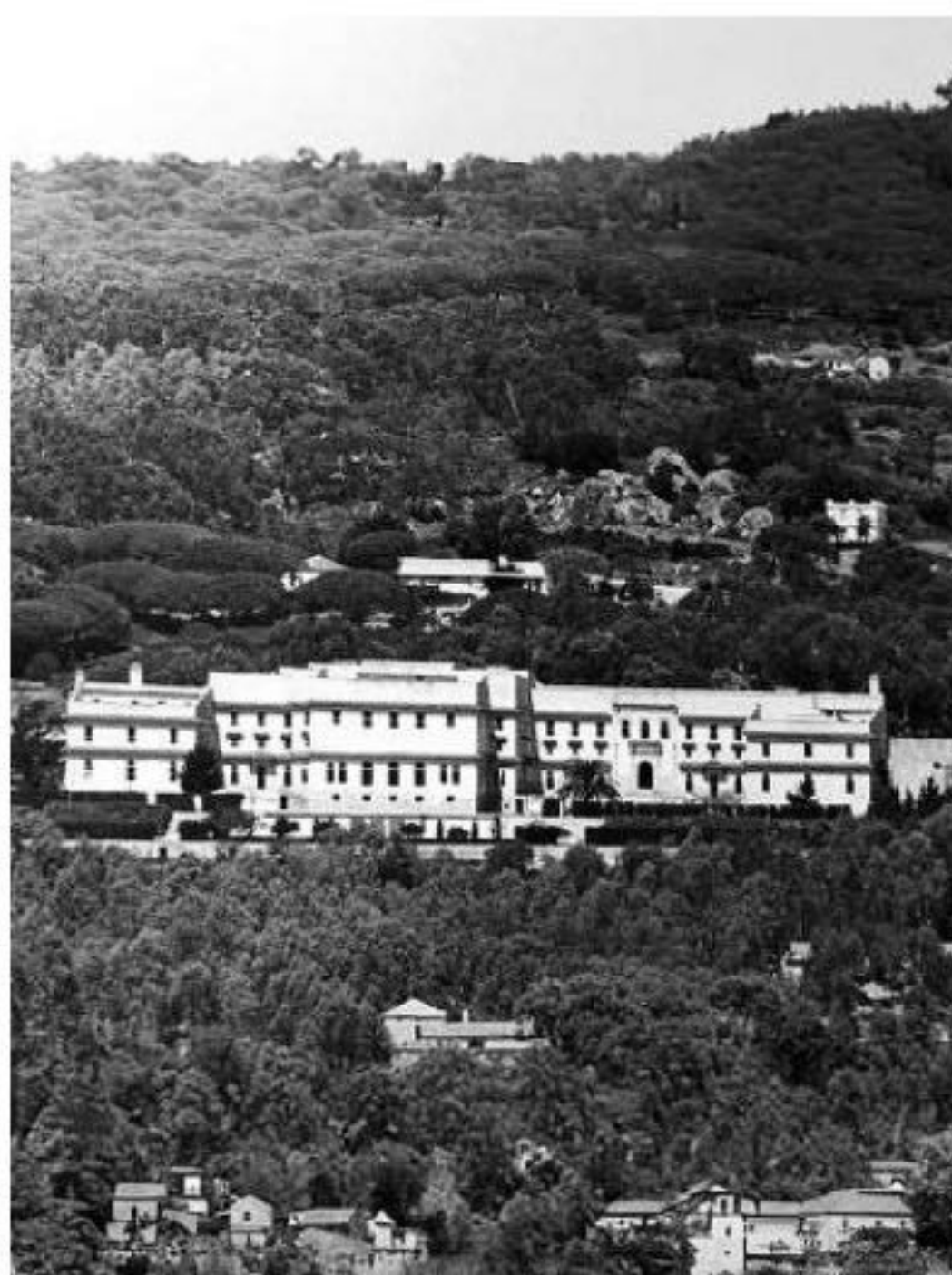
Construit dans les années 1920, le bâtiment était à l'origine la résidence du conseiller du sultan Ahmed Tazi (en haut). Ci-dessus, le palais en 1926.
